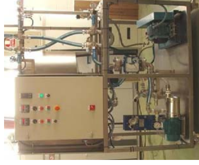
FIG. 5_6. Planta piloto UF UF Experimental facility
